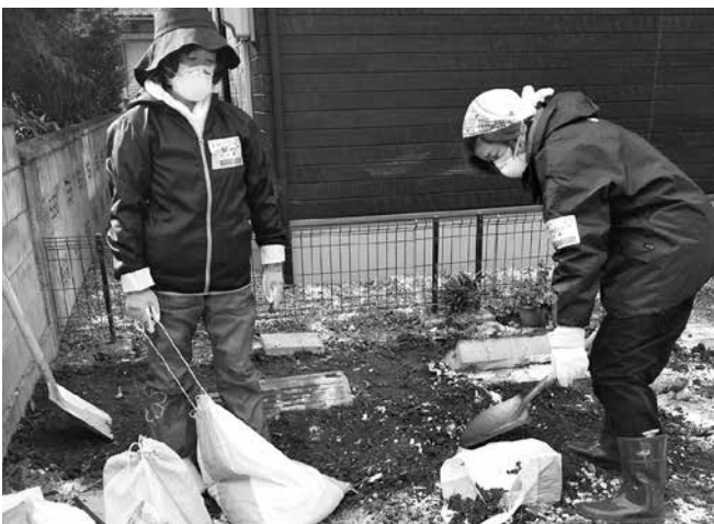
庭に堆積した泥を土裏に入れて運び出す作業
