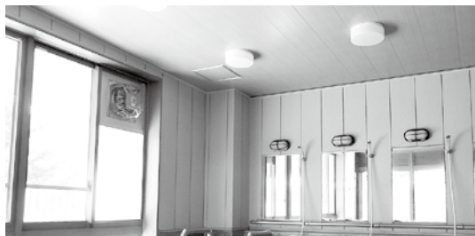
湯気対策に大型の換気扇を設置
