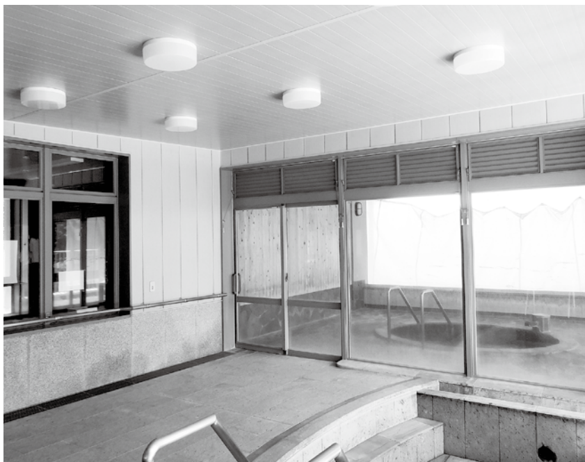
修理が終わった天井、照明も増えて明るくなりました
